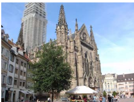
Der Dom in Mulhouse, tw. eingerüstet
