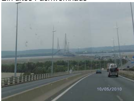
Die Brücke Pont de Normandie
