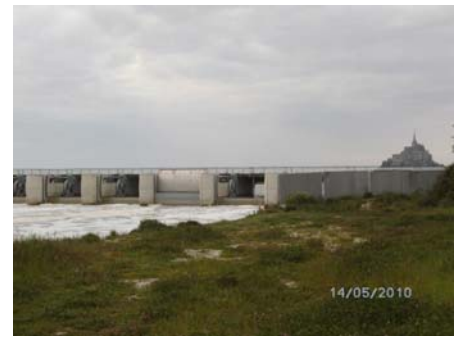
Die Schleuse/Kraftwerk zum Meer
