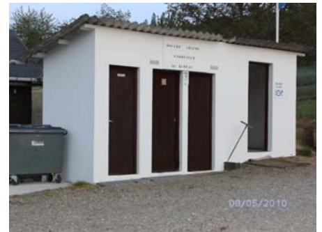
...die Sanitäranlagen eher „dünn“
