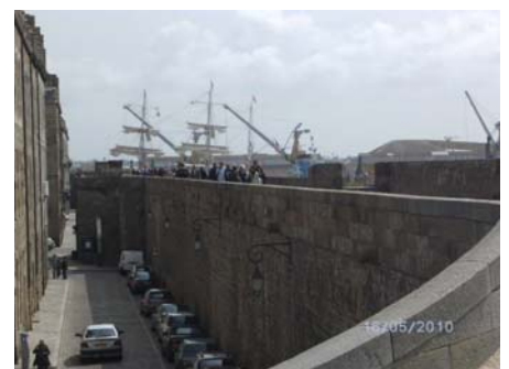
Rundgang auf der Stadtmauer
