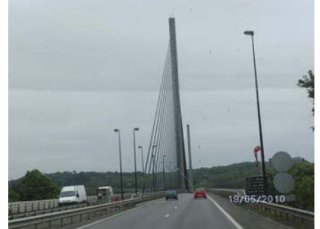
Brücke nach Plougastel
